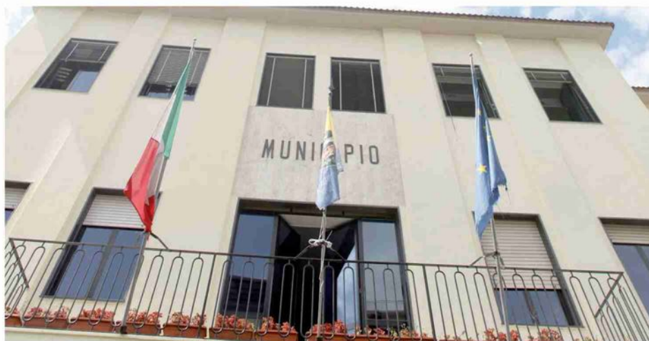
IL COMUNE DI GRAGNANO Cantieri imminenti per installare l'ascensore
