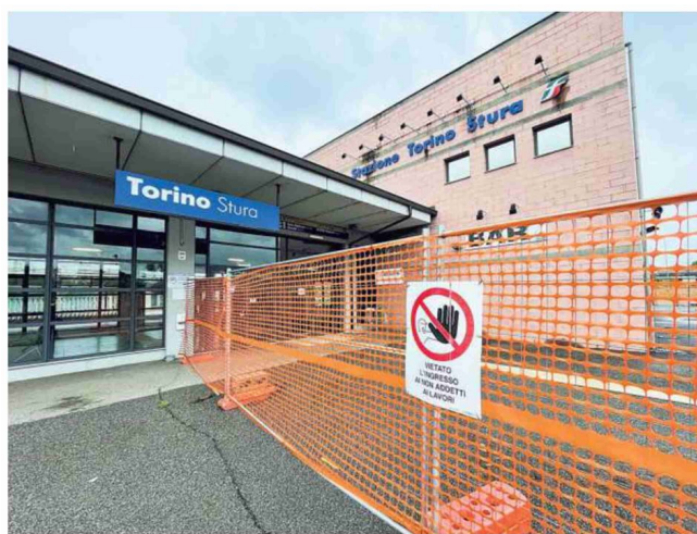
Le reti da cantiere davanti alla porta principale della stazione
