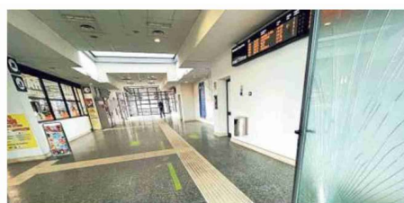
L'atrio si presenta ancora oggi con una vetrata infranta
